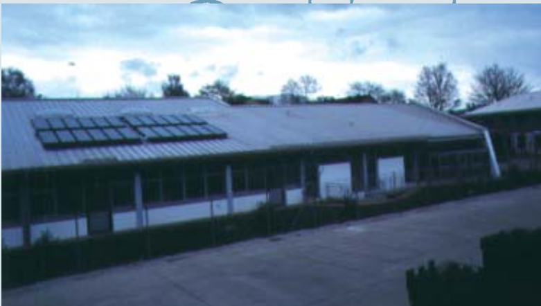
Solaranlage der Lebenshilfe, Neu-Ulm
